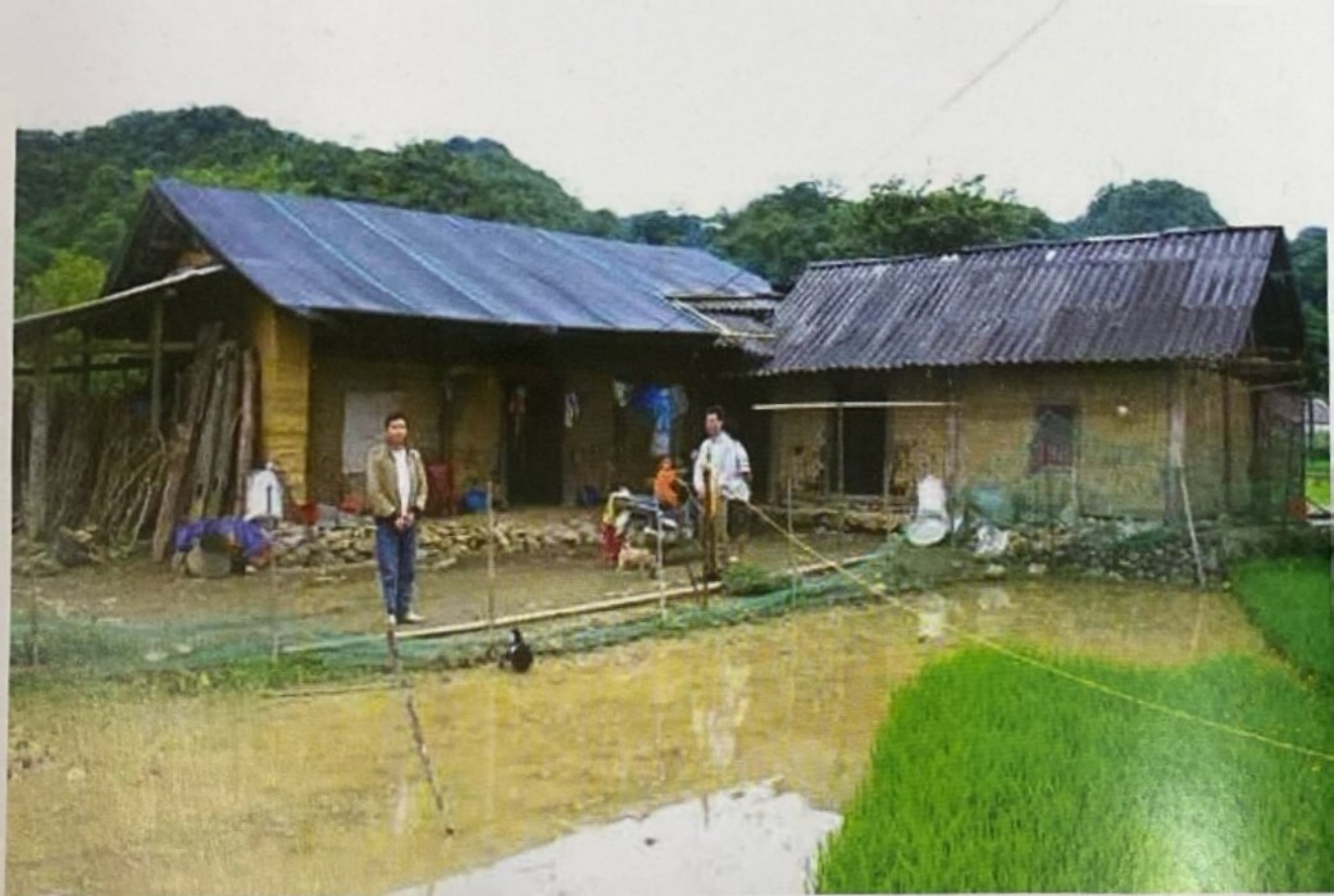
Căn nhà trình tường thực hiện mô hình điểm “chằng néo mái nhà phủ lưới” chống mưa bão của hộ bà Ly Thị Dế, thôn Nậm Lương, xã Quyết Tiến
